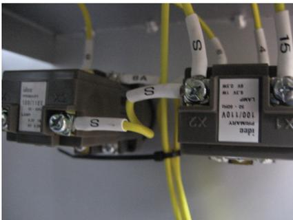
点火、消化スイッチの線が外れていないか確認する。
